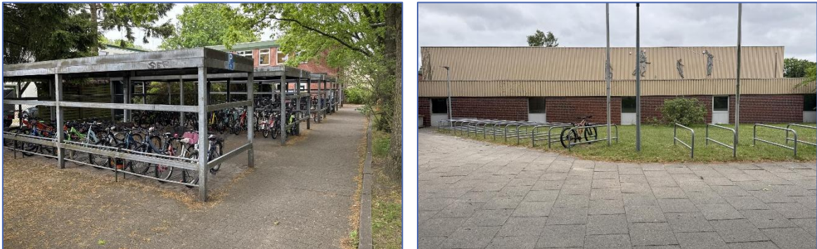
Abbildung 5: Stark genutzte überdachte Abstellanlage (links); kaum genutzte Abstellanlage (rechts)
