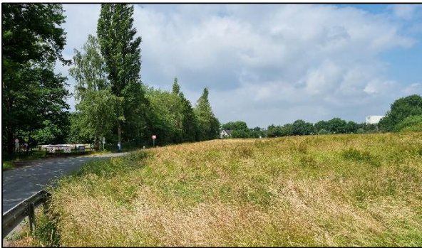
Abbildung 19: Blick nach Südwesten von der Brücke im Osten.
