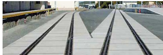
Regelquerschnitt GP- Rand- und Mittelplatten seitlich mit Tiefbord Beispiel für Schiene „54E3“ (S54) mit Oberbau „K“ auf „BS66 I“ Schwelle
