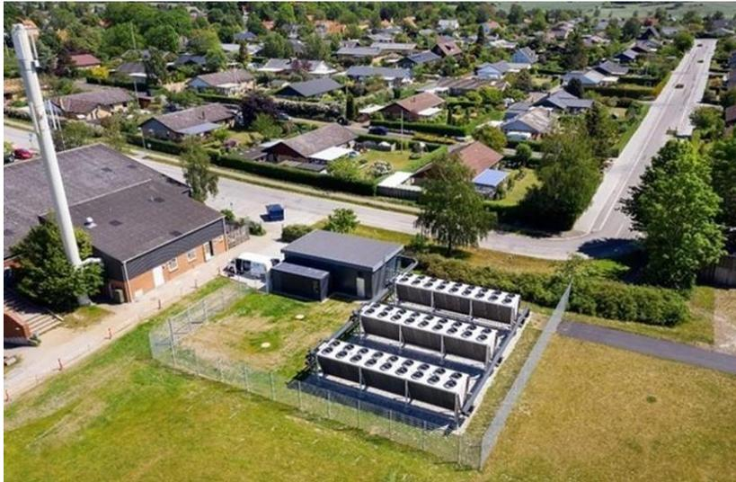
Abbildung 34: 1,2 MW Luft-Wärmepumpe in Slagslund Dänemark (Quelle: PlanEnergi)
